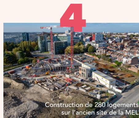
Construction de 280 logements sur l'ancien site de la MEL
